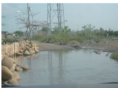
浸水した道路
