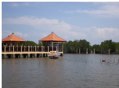
インフラが整ったマングローブ公園
