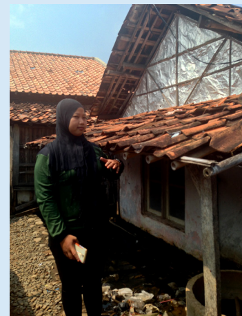
道と床を高くしたので屋根が低くなっている
