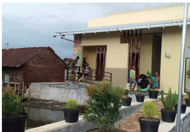
住民参加型で設置した浸水地の適応型トイレ
