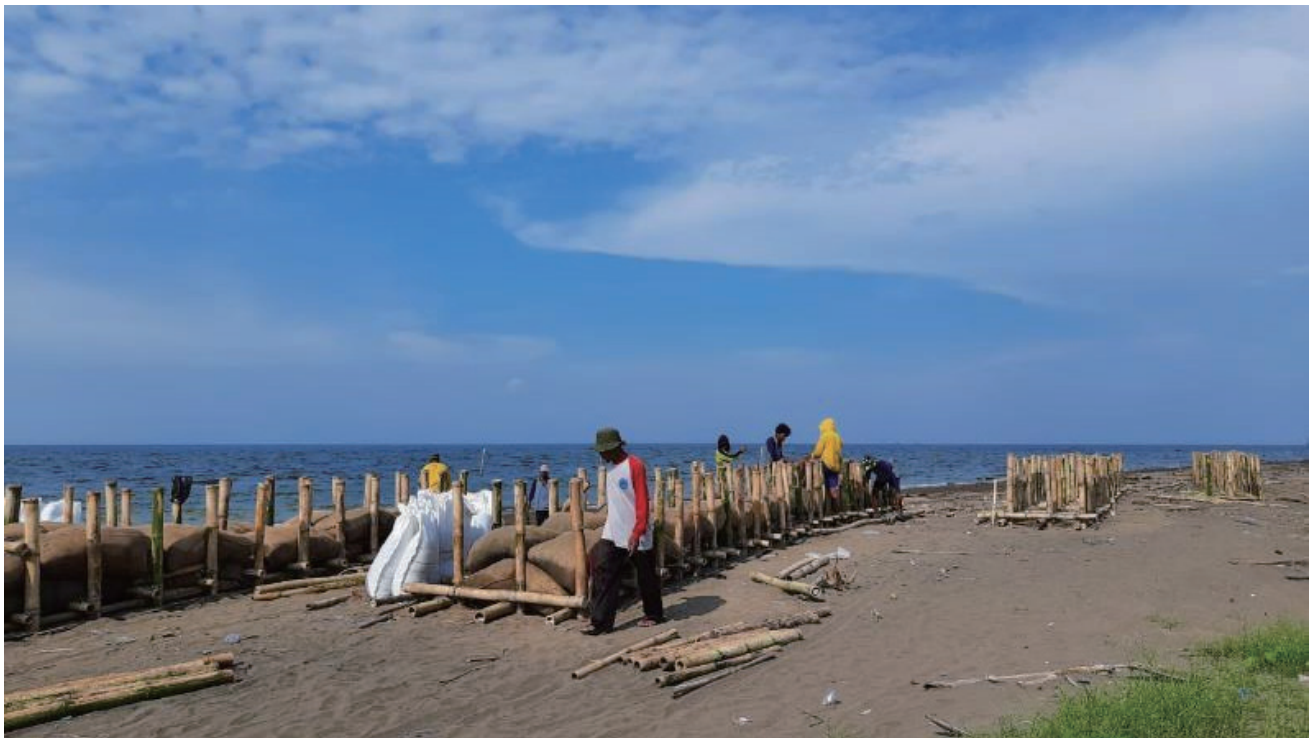
竹と土嚢を使った防波堤の設置
