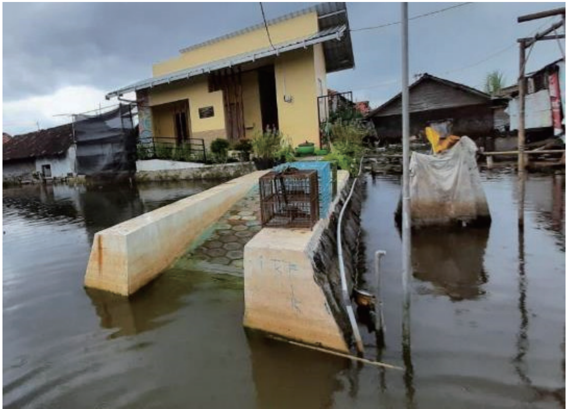
洪水時も浸水被害を受けなかった適応型トイレ
