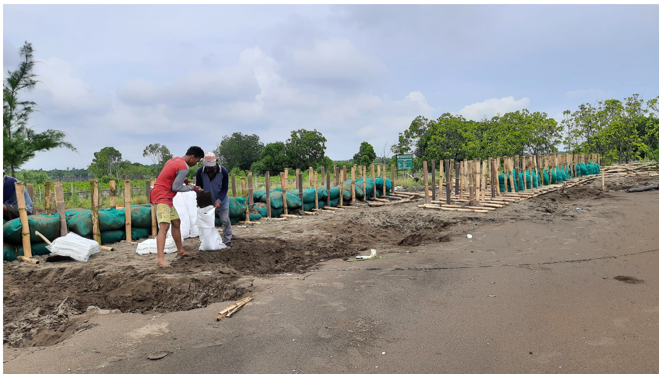
アピ・アピ村沿岸への防波堤の設置
