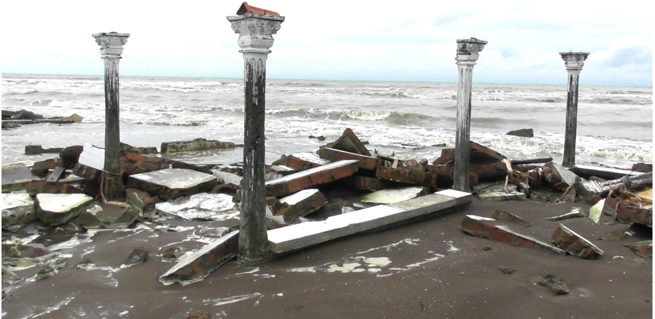
高波により崩れた家屋
