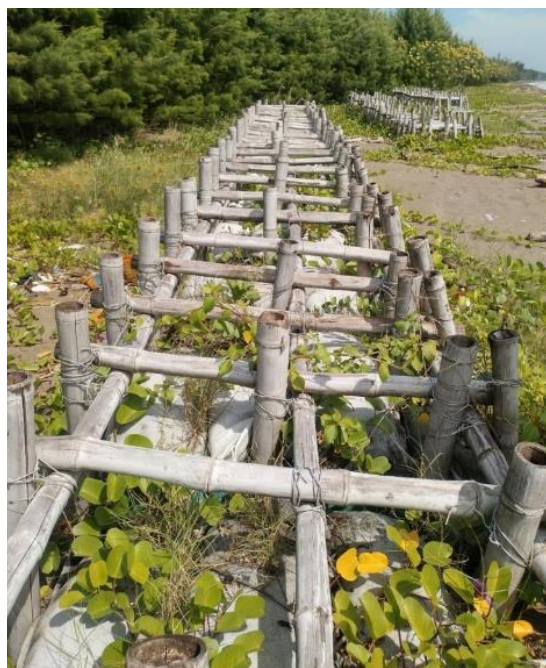
竹を使用した防波堤
