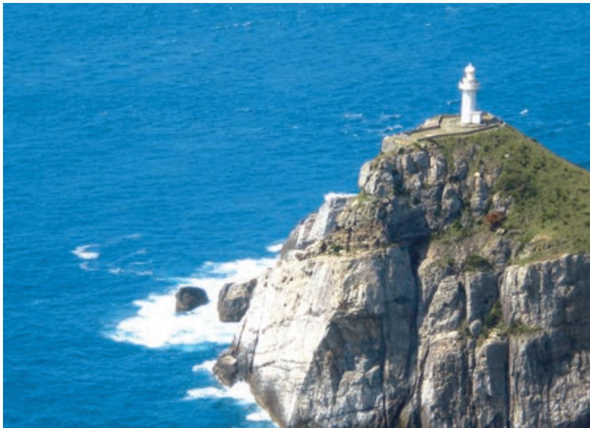
長崎県 大瀬埼灯台
